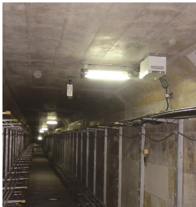
トンネル内での取付けの様子
