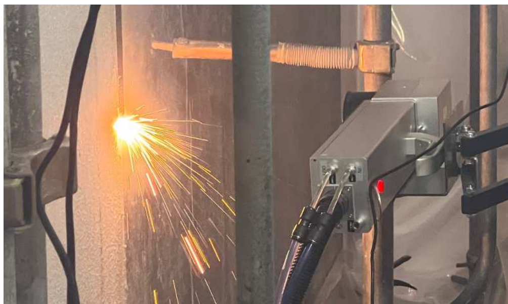
ハイパワーレーザーによるアスベスト除去の検証状況
