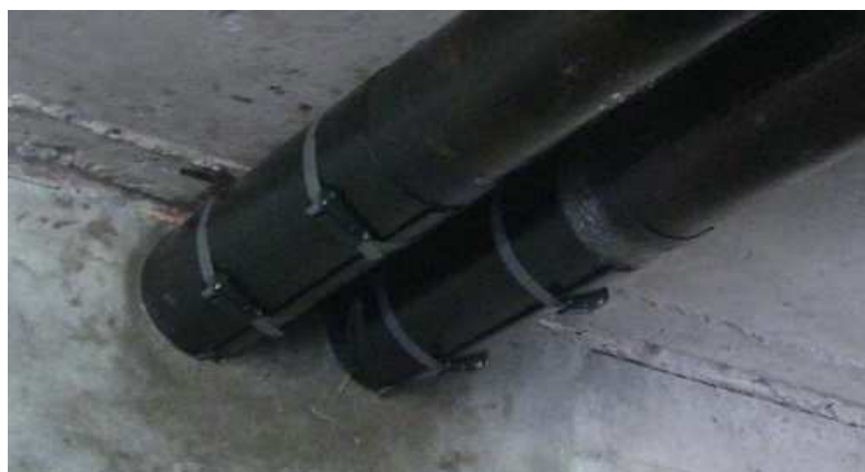
【WI-MARY工法施工状況】
